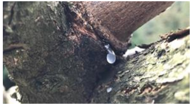
写真2 枝分岐部からの樹液の漏出
